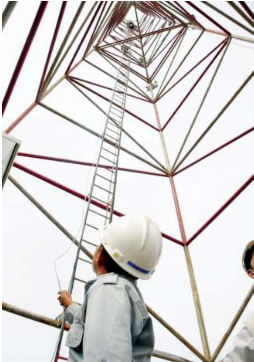
Pemasangan arreses di panel electrical oleh Departemen IT PT IMIP. (foto: Doc:Departemen Eksternal PT IMIP)
