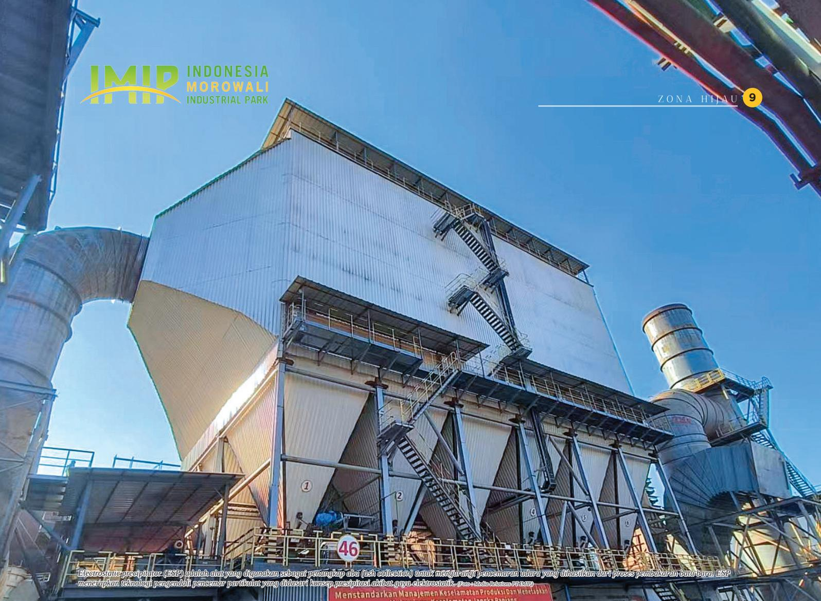
Electrostatic precipitator (ESP) adalah alat yang digunakan sebagai penangkap abu (ash collection) untuk mengurangi pencemaran udara yang dihasilkan dari proses pembakaran batu bara. ESP menerapkan teknologi pengendali pencemar partikulat yang didasarkan konsep presipitasi akibat gaya elektrostatis. (Foto: Media Relations PT IMIP)
