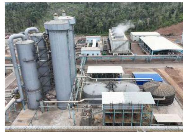
Sistem pembersihan dan desulfurisasi gas hidrogen
