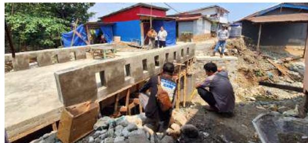
Pembangunan jembatan di dua lokasi area V Bahomakmur
