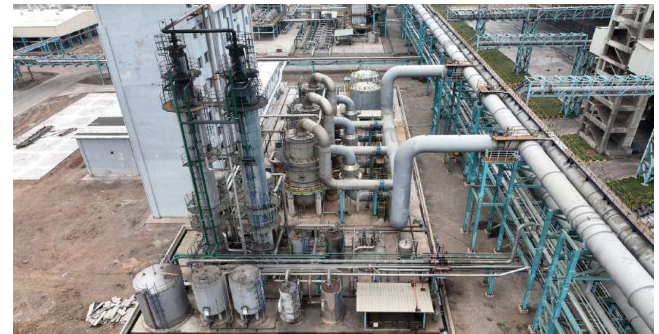
Sistem Pengolahan Limbah Cair Produksi - Sistem penguapan amonia
