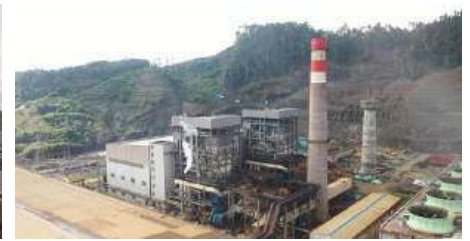
Pembangkit Listrik 2*100MW PT.DSI
