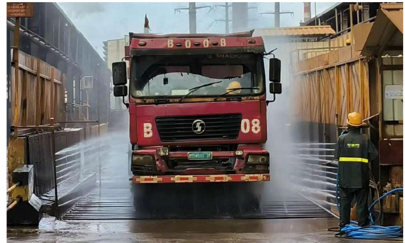
Air hujan yang didaur ulang digunakan untuk mencuci kendaraan di area pencucian kendaraan.
