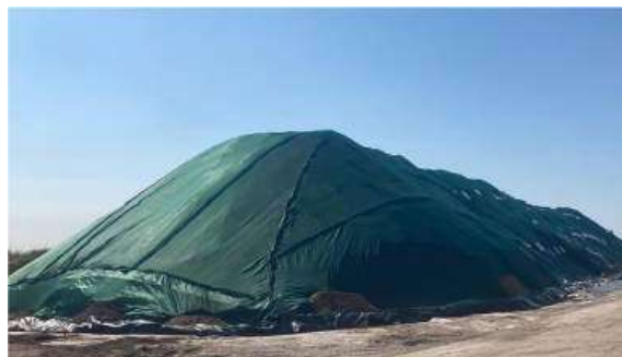
Penutupan dengan terpal hujan
