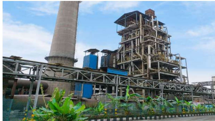
Pembangkit Listrik 25MW PT.IRNC
