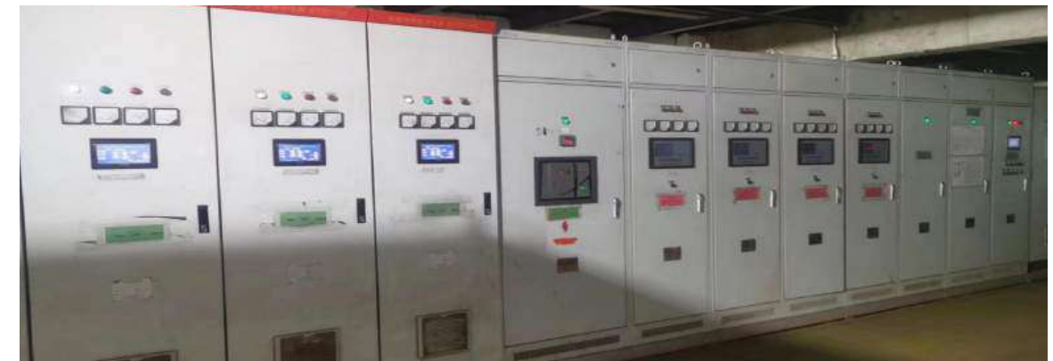
Sistem Kontrol Pulsasi Frekuensi Variabel Cerdas untuk Electrostatic Precipitator (ESP)
