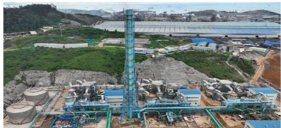
Pembangkit Listrik 2x25MW PT.HYNC
