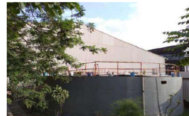
Bak Penampungan Air Limbah Domestik
