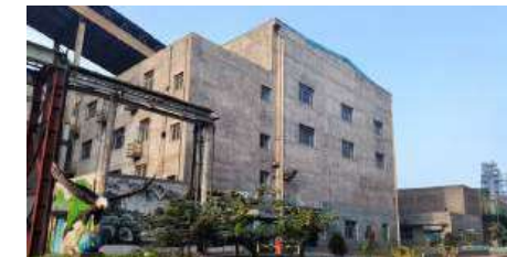
Pembangkit Listrik 1*15MW dari Panas Sisa PT.DSI
