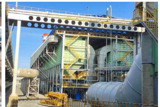
Sistem Pembersihan dengan Metode Adsorpsi Kering Aluminium Oksida
