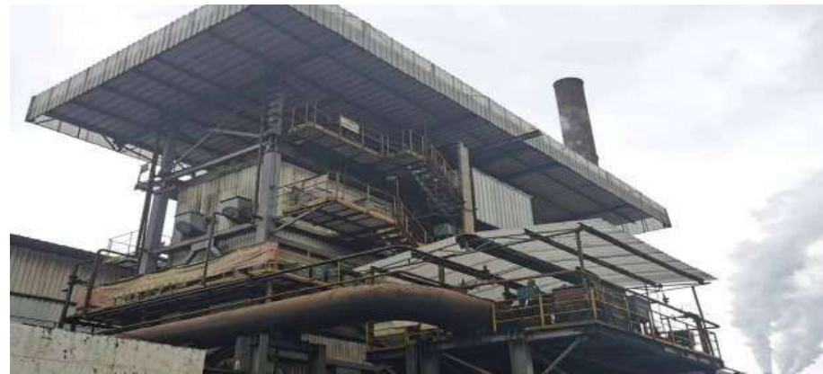
Pembangkit Listrik 7MW PT.TSI
