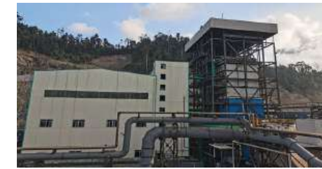
Pembangkit Listrik 1*150MW PT.DSI
