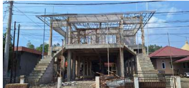
Pembangunan Balai Desa Lalampu
