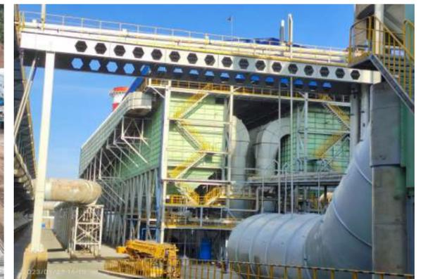
Sistem Pembersihan dengan Metode Adsorpsi Kering Aluminium Oksida
