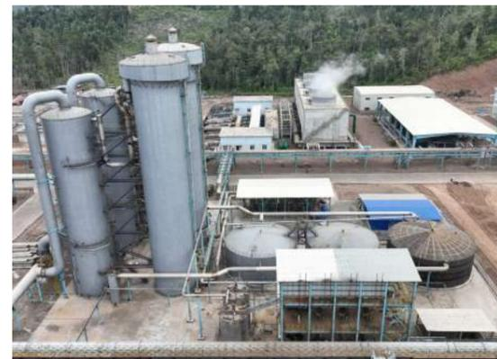
煤气净化脱硫化氢系统
