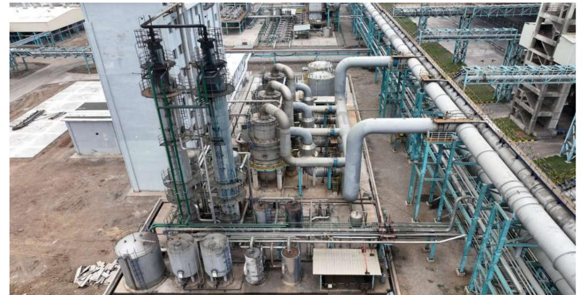
生产废水处理装置 -- 蒸氨系统
