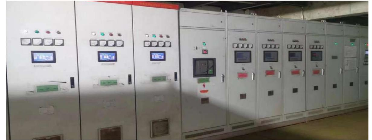
电除尘智能脉冲变频控制系统
